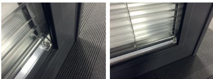
Maintien de la barre de charge par une équerre en plexi de chaque côté. Évite le balancement. Ne permet pas de relever le store. Attention à la réservation entre les 2 vitres.
