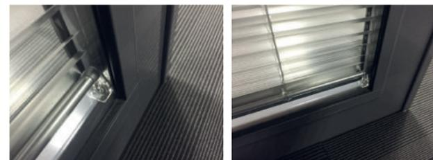
Maintien de la barre de charge par une équerre en plexi de chaque côté. Évite le balancement.
